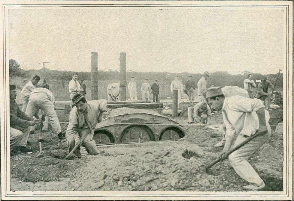
CONSTRUCTION D'UN FOUR DE CAMPAGNE.
